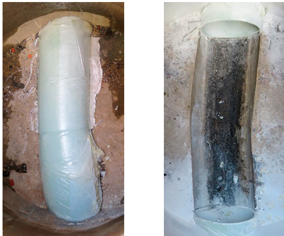
写真6 (左) 連続施工部硬化後、(右) 同部切断状況
