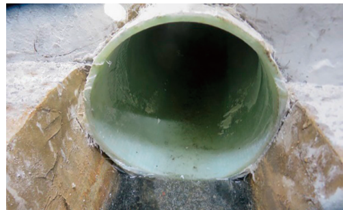
写真10 施工後管口状況（中間マンホール上流）
