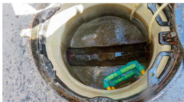
写真2 中間マンホール状況
