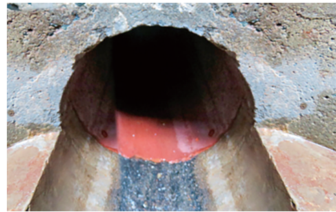
写真9 施工前管口状況（中間マンホール上流）
