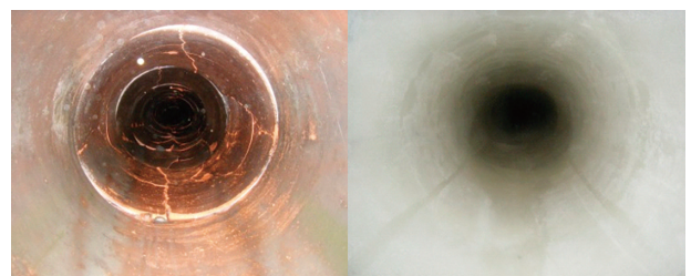
写真1 施工前後の管内状況
