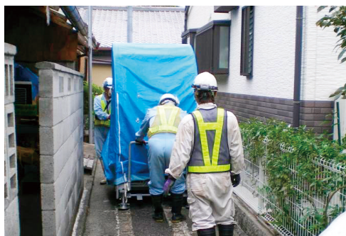
写真2 パイプの小運搬
