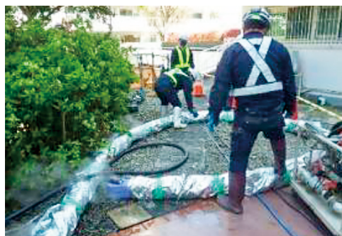
写真7 切り出したパイプの地上予備加熱状況
