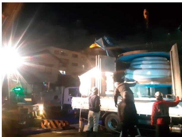
写真3 EXパイプをパイプウォーマーに設置
