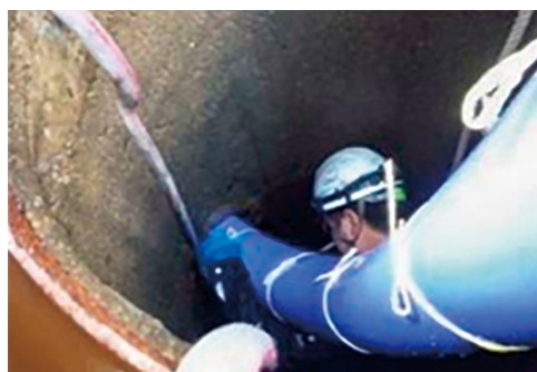
写真8 パイプをロープで結束し管内へ引込
