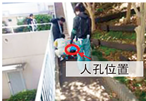
写真6 上流側マンホール地上状況
