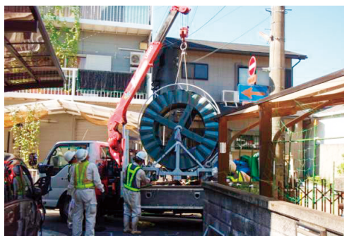
写真1 ドラム荷下ろし
