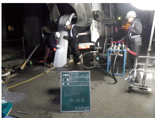
写真4 EXパイプ挿入状況
