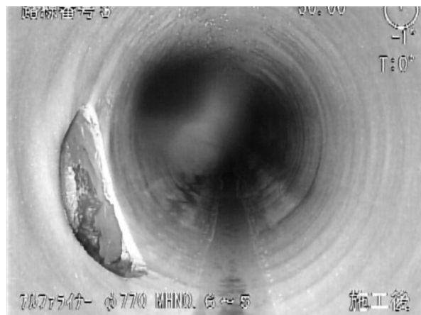
写真9 施工後/50m付近
