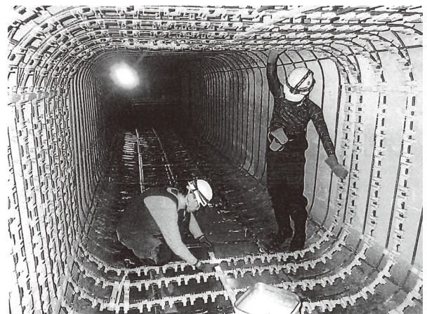
写真2 補強リング設置工程
