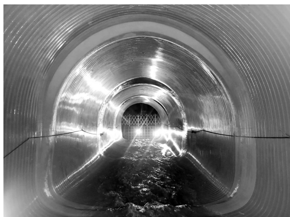
写真4 完成断面（SPR工法）
