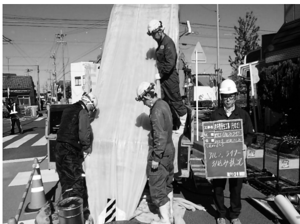
写真3 ライナーの引込み状況
