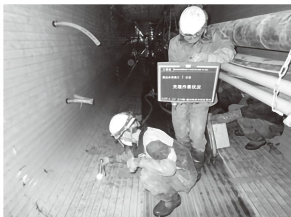
写真5 目視による充填確認状況
