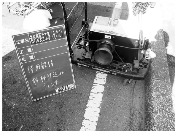
写真4 ライナーの引込み用ウインチ
