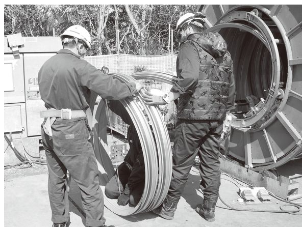
写真5 巻き癖径の計測（SPR-SE工法）
