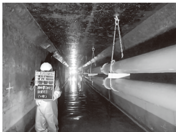
写真3 管内配管設置状況
