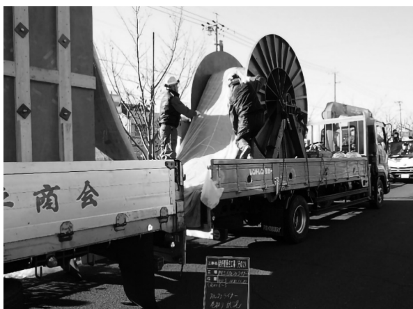
写真2 ライナー引込み補助装置
