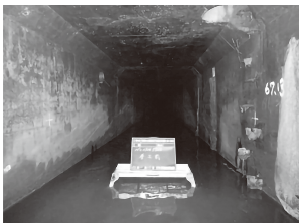
写真1 作業時の管内水位（40cm）
