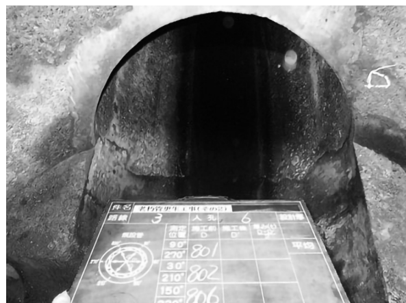
写真10 施工前の管口
