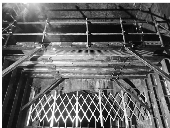
写真3 緊急避難場所（SPR工法）
