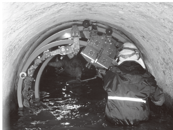
写真6 製管作業（SPR-SE工法）
