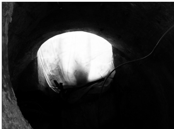
写真6 管口硬化状況
