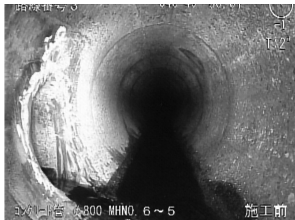
写真8 施工前/50m付近
