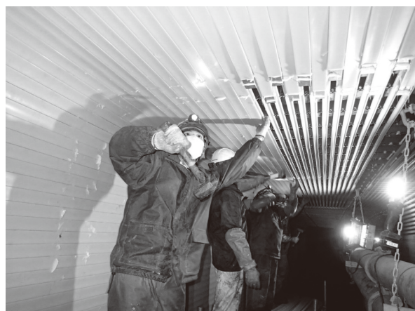
写真4 管内配管状況下での製管作業
