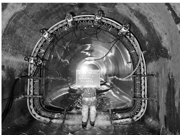
写真1 製管機の流出防止（SPR工法）
