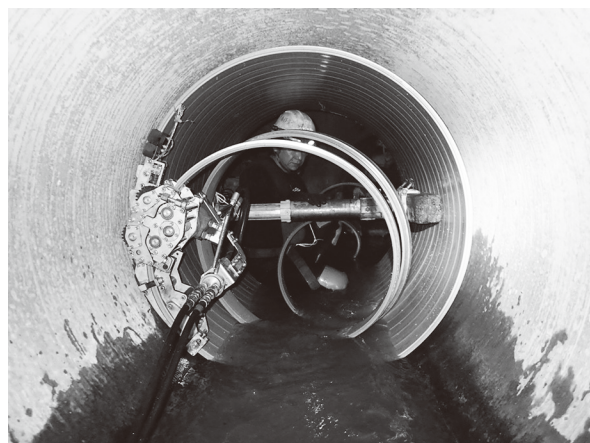
写真7 製管作業（SPR-NX工法）
