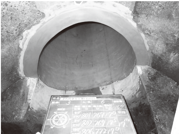
写真11 施工後の管口
