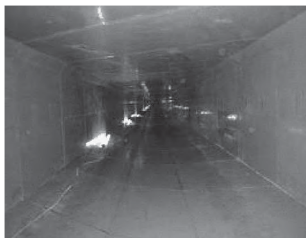
更生工法による再構築後の幹線
