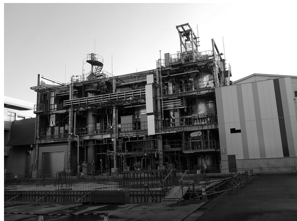
写真1 下町浄化センターの過給式流動焼却炉
