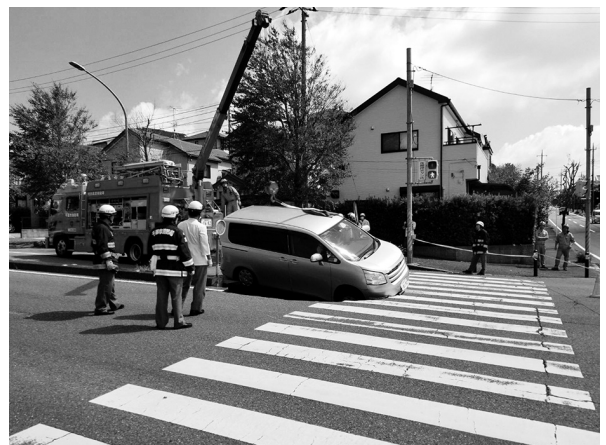
写真2 （参考）あすみが丘で起きた道路陥没（下水道管に起因）
