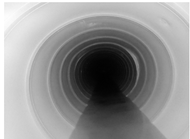
【参考】更生工事の施工状況（円形管、施工前（左）、後（右））
