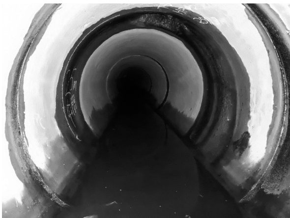
【参考】更生工事の施工状況（円形管、施工前（左）、後（右））
