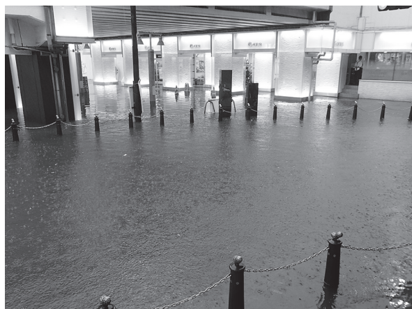
写真1 令和元年10月25日に房総地区を襲った豪雨での大規模な浸水被害状況
