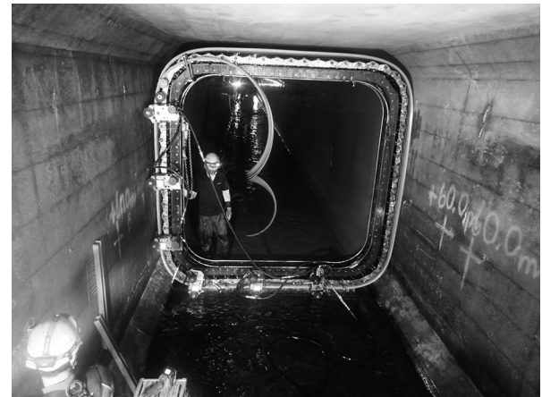
【参考】更生工事の施工状況（矩形きょ）
