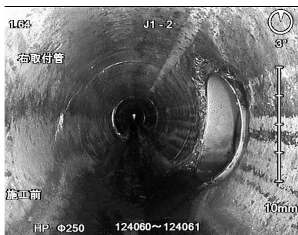
写真2 本管改築更生工事（着工前・完成）
