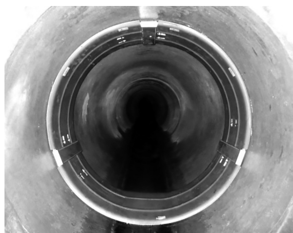
写真3 人孔と本管接続部 耐震化工事（着工前・完成）
