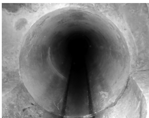
写真3 人孔と本管接続部 耐震化工事（着工前・完成）
