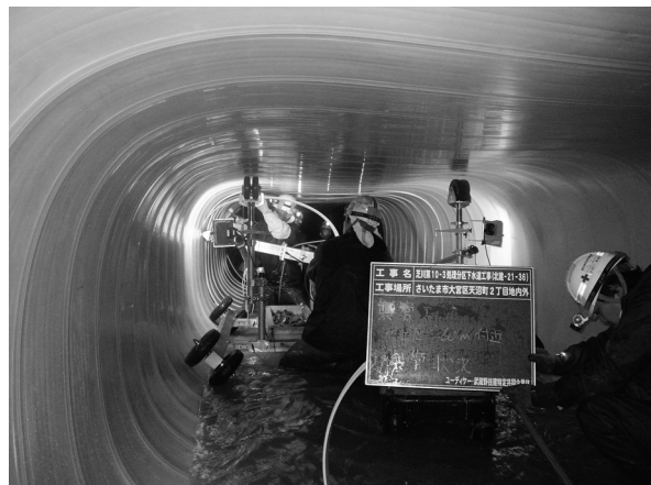
管路更生工事の状況（施工中）
