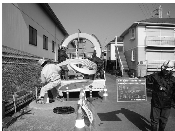
管路更生工事の様子
