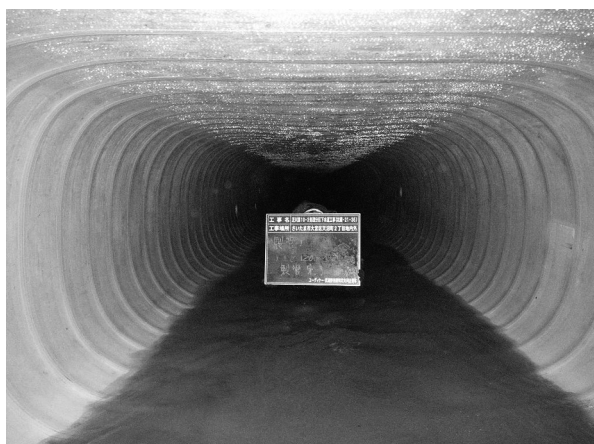
管路更生工事の状況（施工後）
