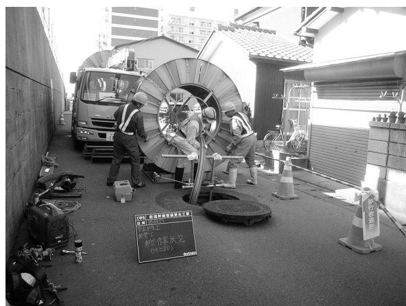
管更生施工状況 2
