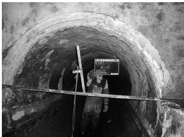
管更生工事の様子（施工前）
