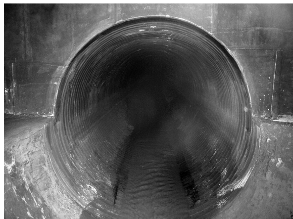
管更生工事の様子（施工後）
