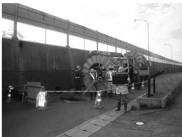
管更生施工状況 1
