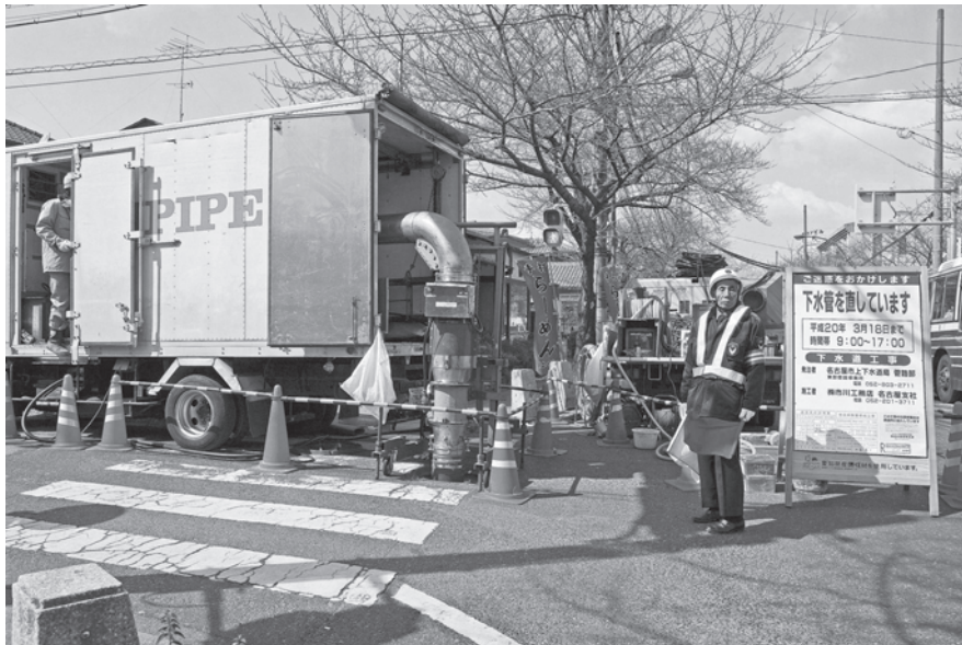
更生工法施工中のよう
